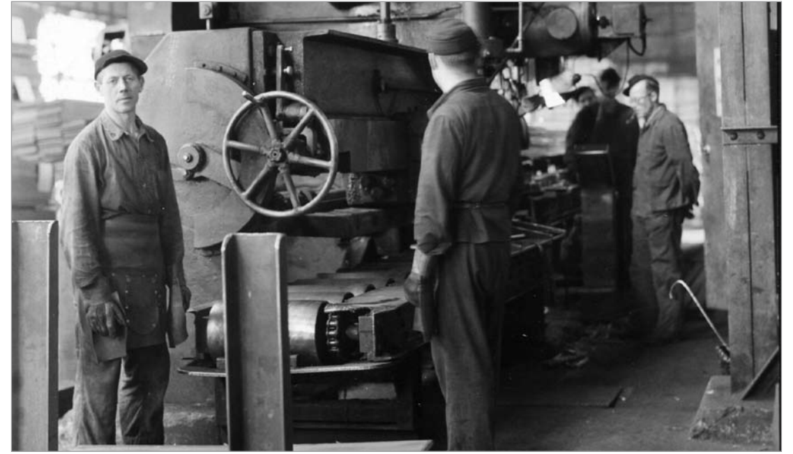
Abb. 7: Platinschere im Betrieb bis 1954 (Fotograf: Hoesch Siegerlandwerke, Archiv Nr. 176, Originalbeschriftung ca. 1952, Stadtarchiv Kreuztal)
